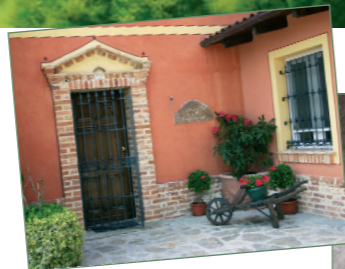
Il recupero dei materiali
