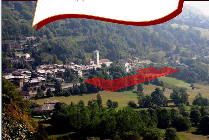
Vista dell'ubicazione del nuovo Complesso residenziale Villaggio S. Martino.
